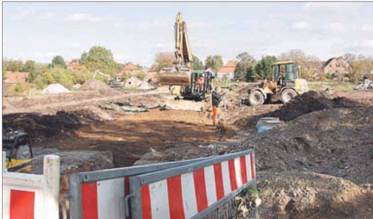
Der Bereich an der Straße Im Wiesengrund wird derzeit noch erschlossen.
