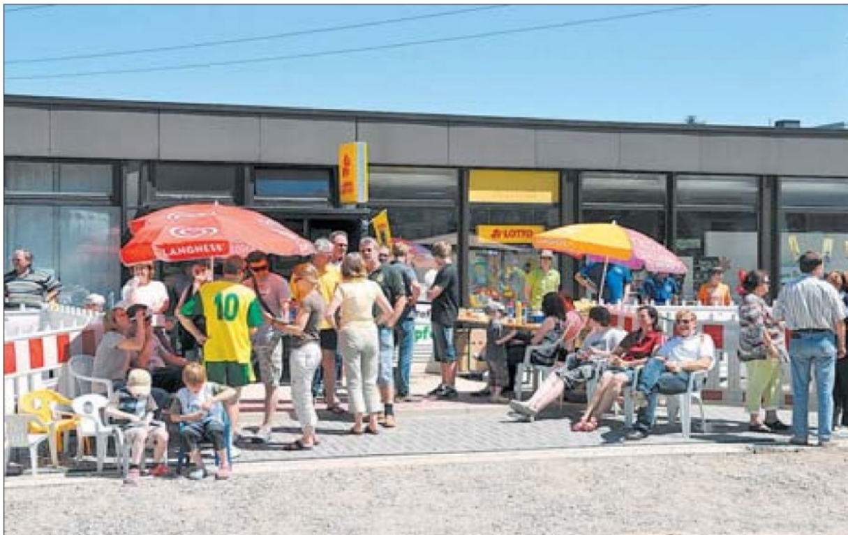
Dorffestatmosphäre mitten in der Baustelle: Vor dem Kiosk an der Straße Zum Großen Freien herrscht reger Betrieb. Die Stadt Lehrte hat sich zuvor eigens dafür eingesetzt, dass der Bürgersteig und die Parkbuchten vor der Verkaufsstelle früher als geplant gepflastert werden. Eggers (2)
