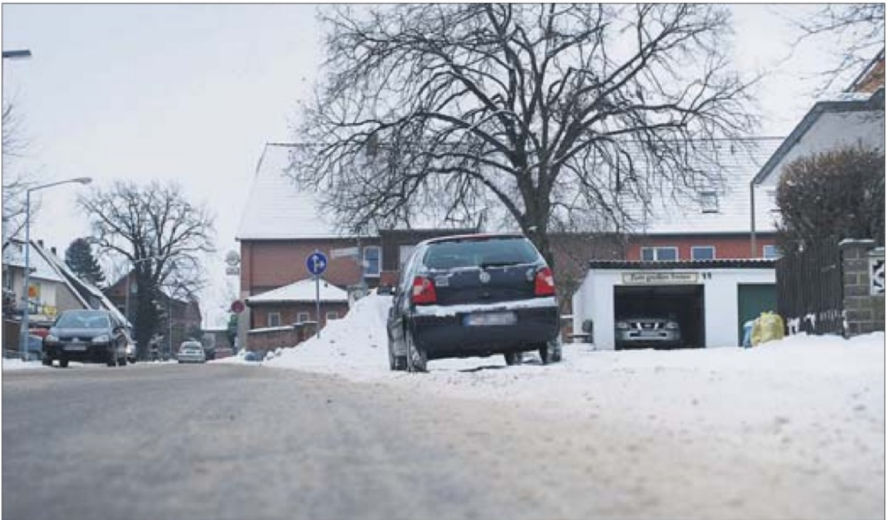
Unter dem Asphalt der Straße Zum großen Freien modert die Kanalisation vor sich hin. Auch die 40 Jahre alte Fahrbahn ist schadhaft. Brunhöber (3)
