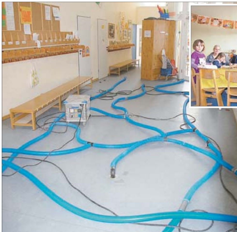
Blaue Schläuche im Flur: Der Estrich im Kindergarten am Saturnring wird zurzeit mit Spezialgerät trockengelegt (großes Bild). Die meisten Kinder sind derweil in Räume der Grundschule umgezogen (kleines Bild). Schütz (2)
